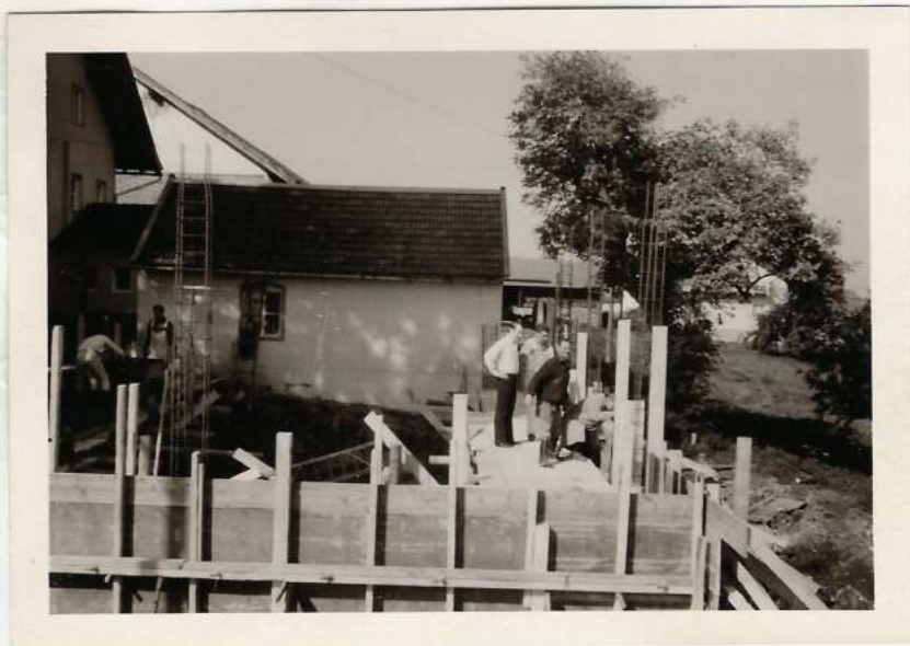
JNG. FRANZ GADENZ, RICHARD ZELZER UND MARTIN DOPPLER BETRACHTEN DIE FERTIGE SCHALUNG.
