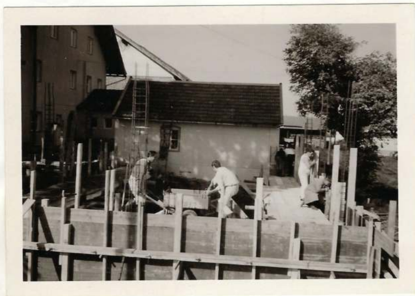
SETZT WIRD BETONIERT.
