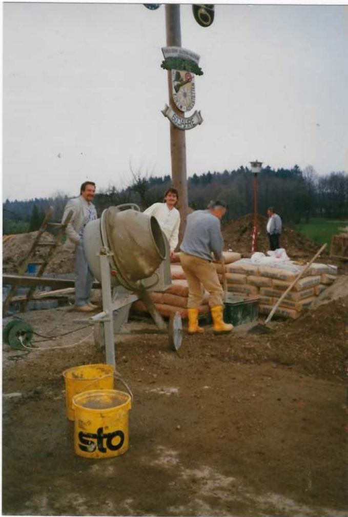
Diesmal war unser Schützenmeister an der Betonmaschine ..
