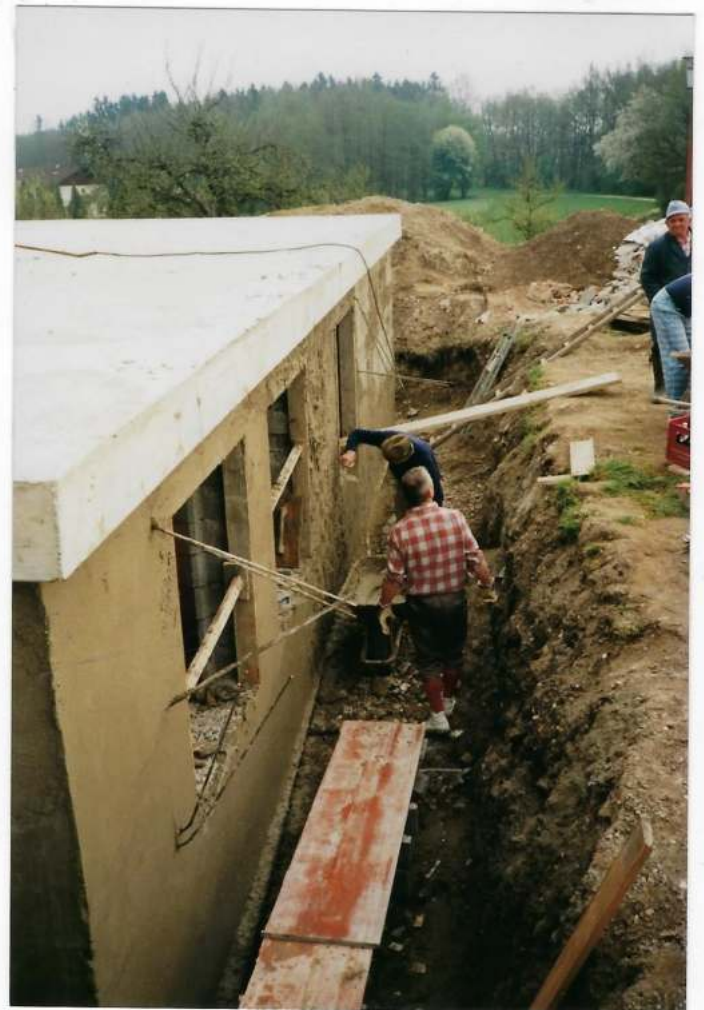
... Dann bringen wir den Außenputz und den Isolieranstrich an.
