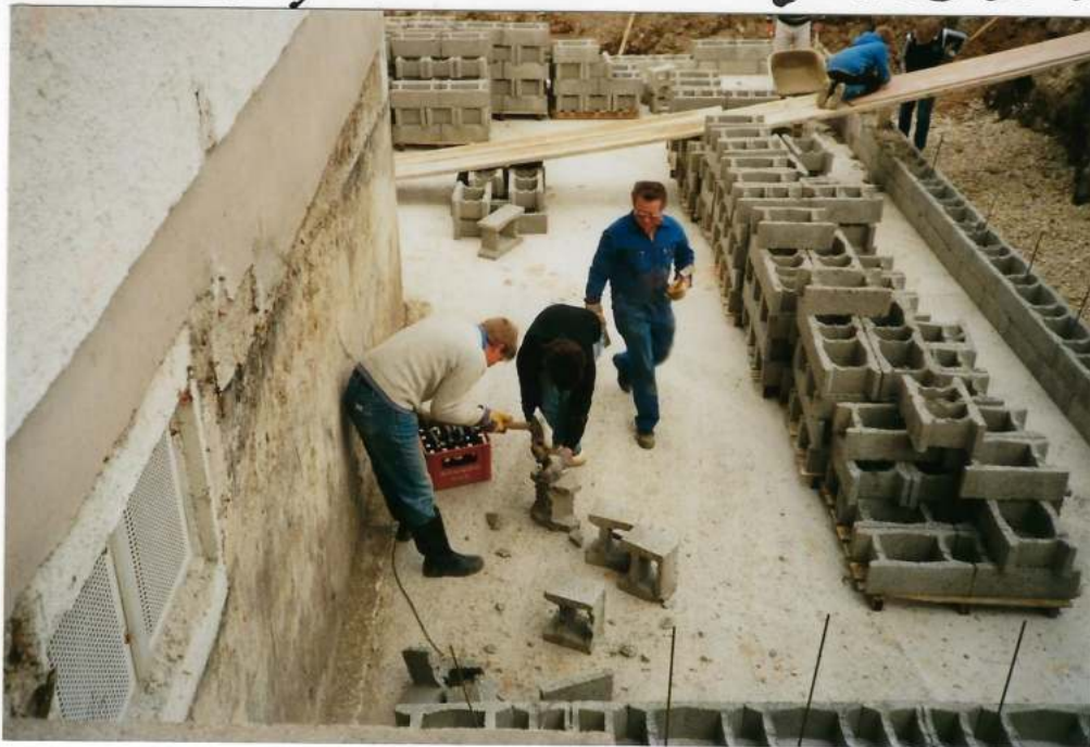
Die Mauer wächst ...
