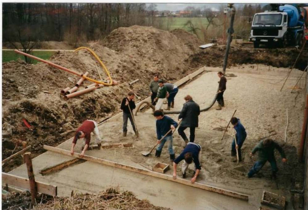
Dann betonierten wir die Kellersohle... Eifrig sind wir bei der Sache.
