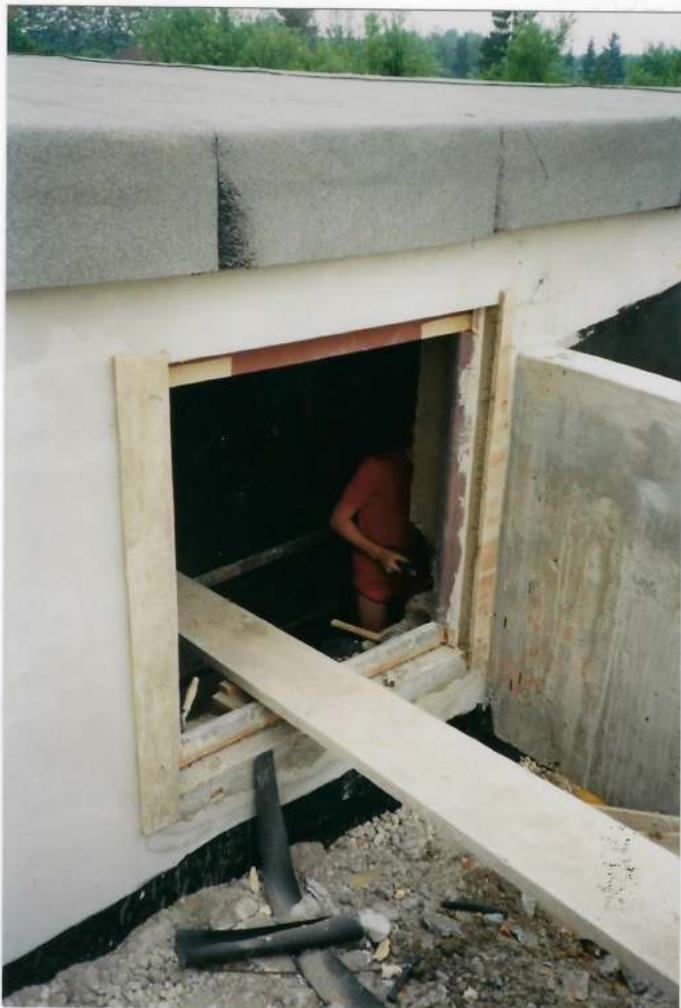
... Dann bringen wir den Außenputz und den Isolieranstrich an.
